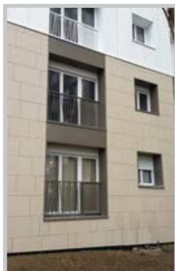
Soubassement en pierre, réfection des fenêtres et garde-corps
